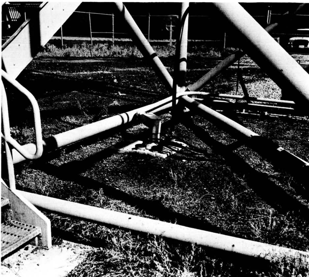
FIGURE 7.—Inter-tower conduit terminus.
