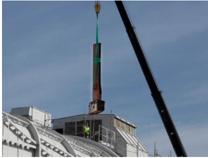
Removal of fan blade
