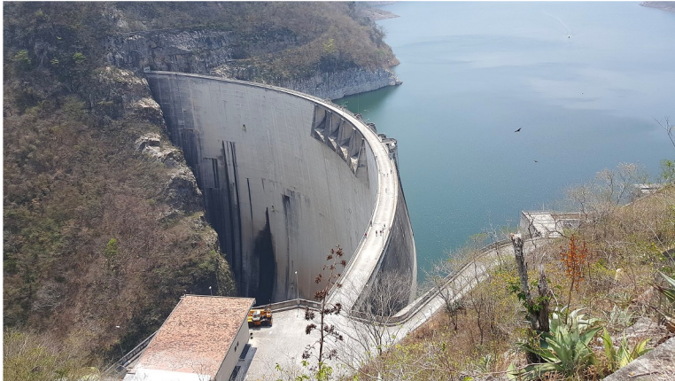
Image of El Cajón dam structure | Credit: Wikimedia Commons
