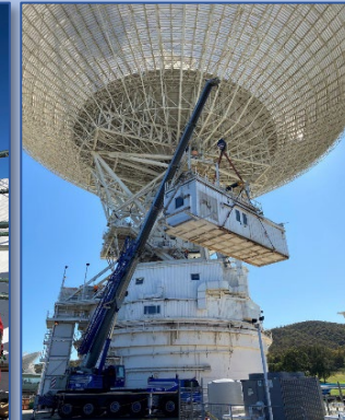
Alidade Pump House removal
