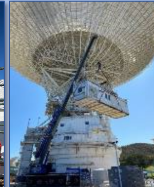
Alidade Pump House removal
