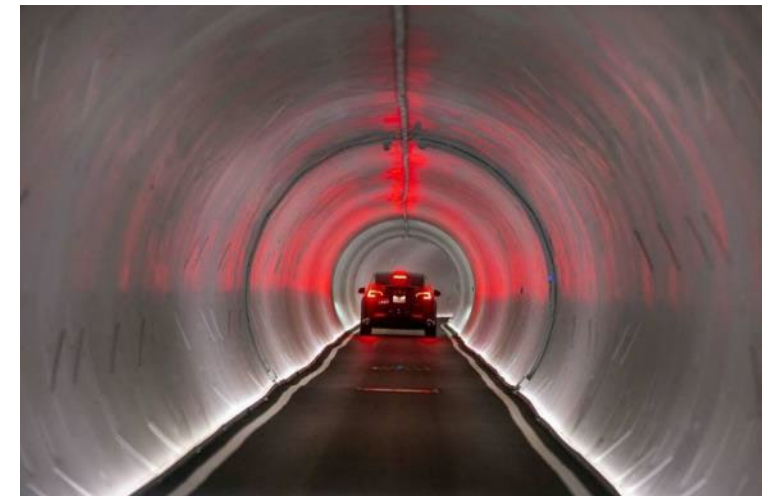
Tesla tunnel under Las Vegas
