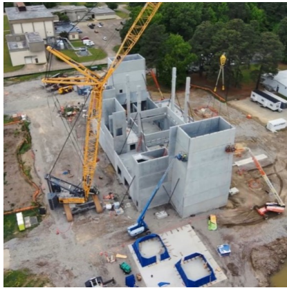
(d) Precast erection, Apr. 2023
