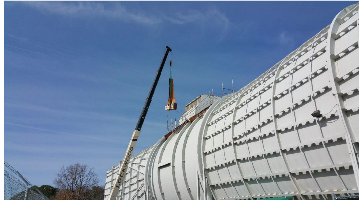
Fan Blade Removal 2015
